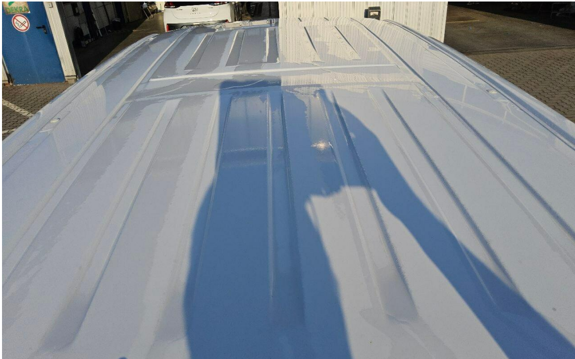
Bild 5 : Dach von hinten nach vorne
