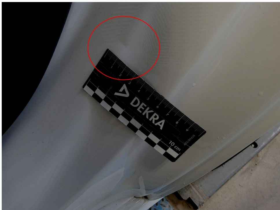
Bild 20 : Einstieg hinten links eingedellt
