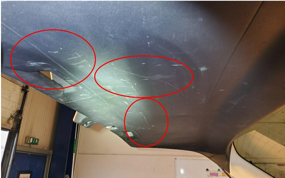
Bild 9 : Heckklappe, Innenverkleidung stark verschrammt
